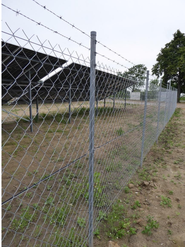
Fotografia 21 Ogrodzenie przedsięwzięcia – bez podmurówki (źródło: zdjęcie własne)
