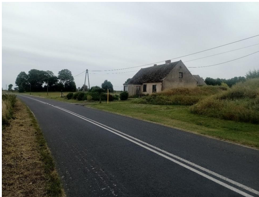
Fotografia 33 Punkt nr 8 – widok na zabudowę zagrodową zlokalizowaną na południe od dz. ewid. nr 3/4 (źródło: fotografia własna)
