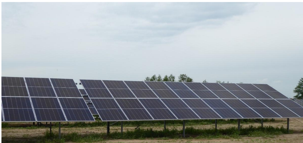
Fotografia 16 Panele zamontowane na stołach
