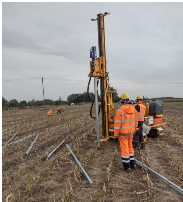
Fotografia 25 Prace budowlane na farmie fotowoltaicznej – kafarowanie (Zdjęcie: Wento)
