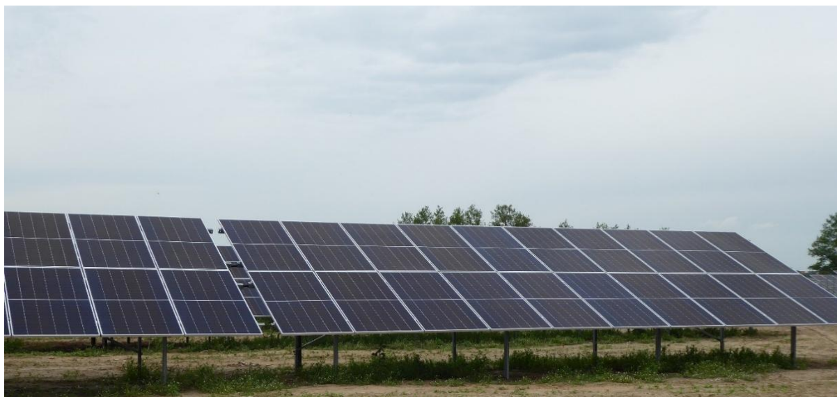
Fotografia 1 Panele zamontowane na stołach (źródło: zdjęcie własne)
